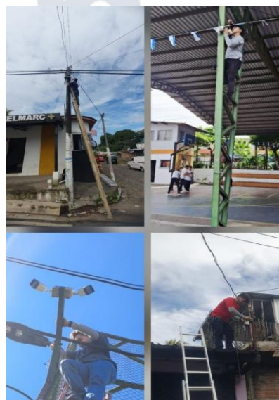
Ilustración 11: Reparaciones, cambios y nuevas instalaciones en diferentes lugares de la LLO
