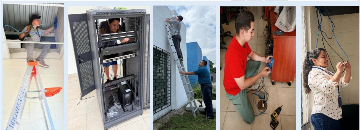
Cableado estructurado y colocación de AP en Cuyagualo.
