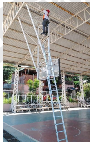
Tendido de cableado para la cancha municipal de basketball de Jayaque.
