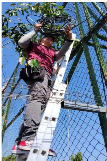
Tendido de Cable del Circuito de Videovigilancia del Polideportivo Lourdes.
