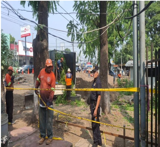
Tala y poda de árboles que generaban peligro en los parqueos del mercado
