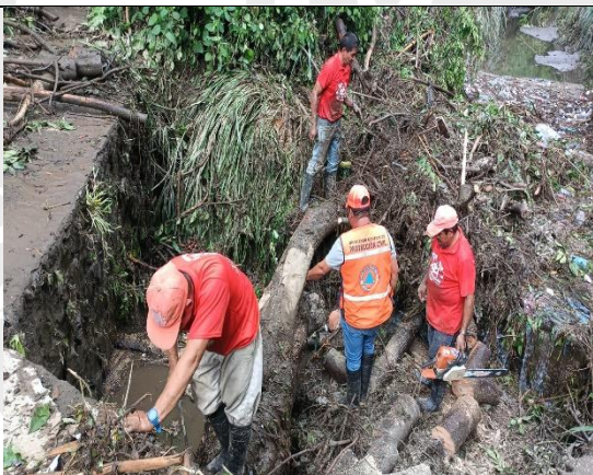
Intervención de tragantes obstruidos.
