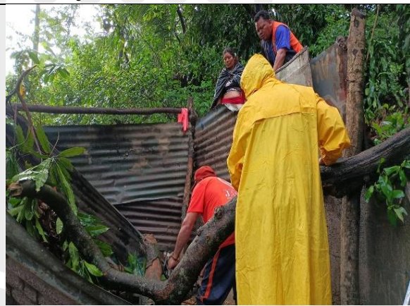
Intervención de árboles sobre viviendas
