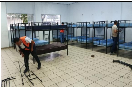
Instalación de albergues para emergencia
