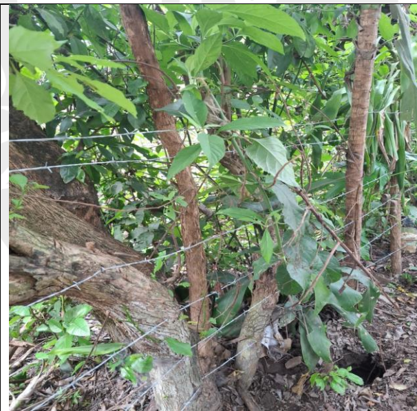
Reparación de 110 metros de cerco perimetral en la zona # 1 cementerio Lourdes
