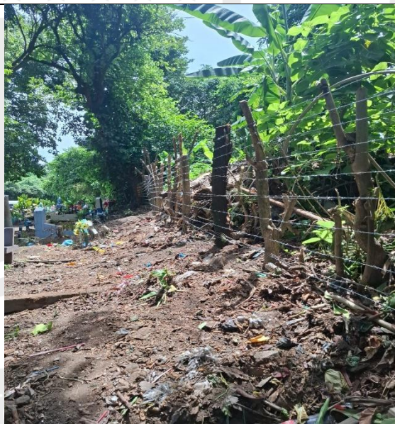
Reparación de cerco perimetral 33 metros en la zona 4 cementerio Lourdes
