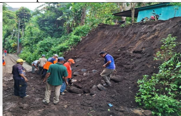
Intervención de muro colapsado sacacoyo
