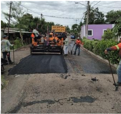
Mantenimiento con mezcla asfáltica en calle a las Conchitas
