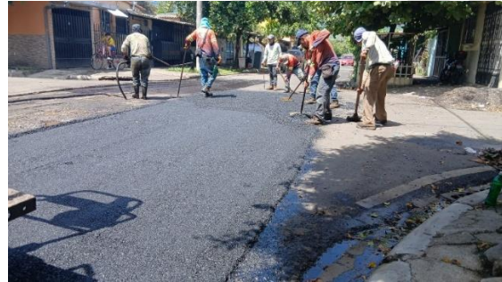
Mantenimiento con mezcla asfáltica en calle a las Conchitas
