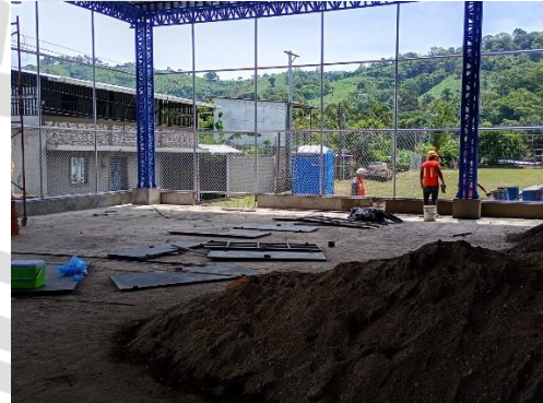
Proyecto de Entechado y mejoramiento de cancha basquetbol distrito de Talnique.
