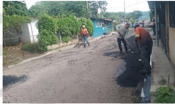
Mantenimiento con mezcla asfáltica en calle a las Conchitas
