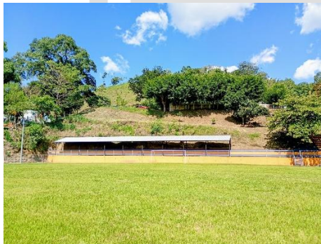
Proyecto remodelación de cancha municipal de colon
