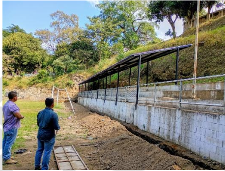
Proyecto remodelación de cancha municipal de colon
