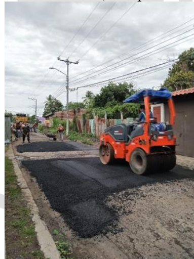
Mantenimiento con mezcla asfáltica en calle a las Conchitas.
