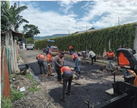
Mantenimiento con mezcla asfáltica en Av. el río, campos verdes II
