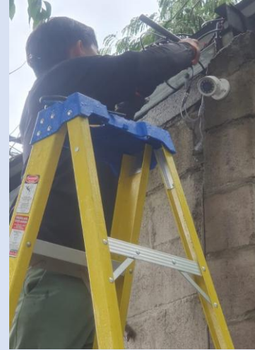
Instalación de cableado para DVR y cámara para Mercado Lourdes
